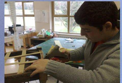
Lavori di restauro
